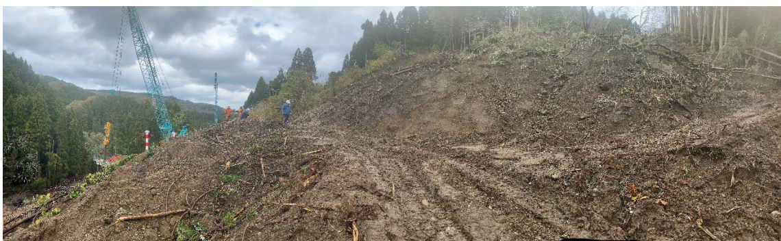
写真-4 地震・豪雨後の被害調査 (中屋トンネル坑口手前付近)
