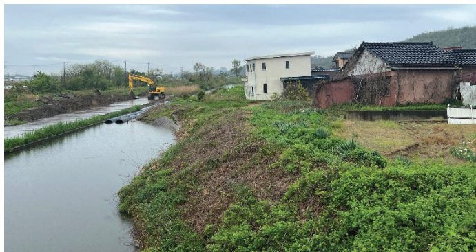
液状化に伴う側方流動被害
