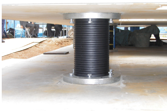
写真1 実用化した積層ゴム支承の施工
